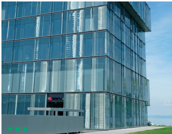
Illustration 9: Enveloppe du bâtiment avec lamelles métallisées dans l'espace entre les vitres. La surveillance exercée pendant une année a confirmé qu'aucune collision n'était survenue. © Archives de la Station ornithologique suisse
