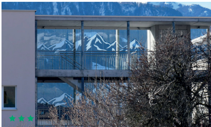
Illustration 12: Les couloirs de communication vitrés sont des pièges classiques pour les oiseaux. La solution décorative mise en œuvre a posteriori par cette maison de retraite est exemplaire. © Christoph Meier-Zwicky
