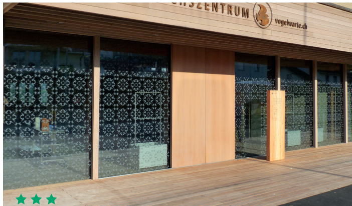
Illustration 7: Les vitres du centre de visite de la Station ornithologique suisse ont été décorées d'un mandala d'oiseaux pour protéger ces derniers des collisions (impression numérique). © Archives de la Station ornithologique suisse
