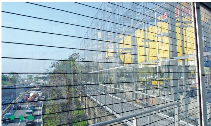
Illustrations 13 (en haut) et 14 (en bas): Des lignes nettes à fort contraste réduisent le risque de collision pour les oiseaux tout en offrant une transparence élevée pour les passerelles pour piétons, par exemple. © Médiation viennoise de l'environnement, Wilfried Doppler; archives de la Station ornithologique suisse (14)
