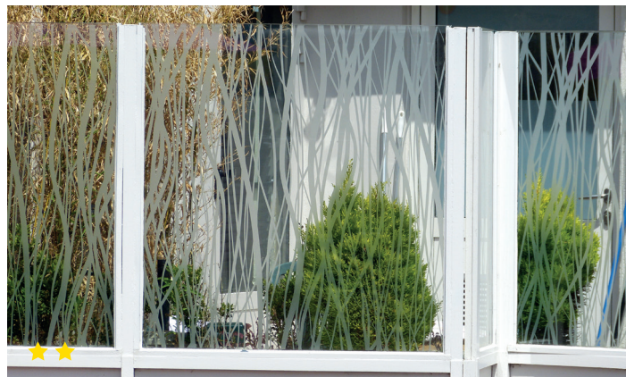
Illustration 15: Un design végétal permet d'éviter les collisions d'oiseaux avec cette paroi coupe-vent. © Archives de la Station ornithologique suisse
