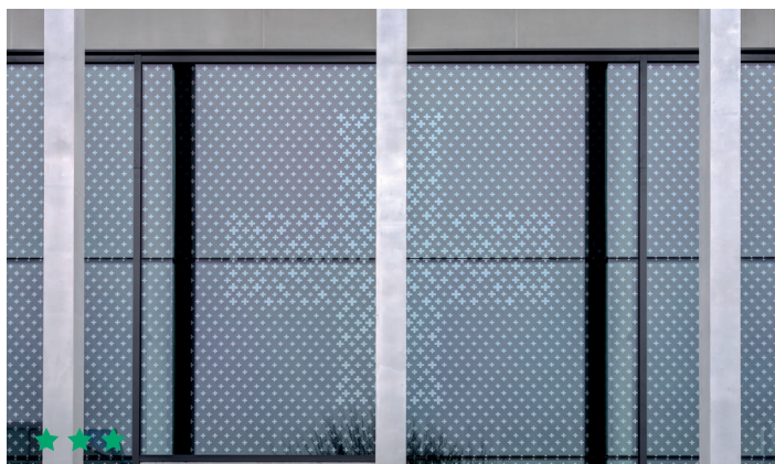
Illustration 8: On trouve également une réalisation exemplaire sur la place d'armes de Frauenfeld: la surface vitrée du centre de subsistance arbore un marquage visant à éviter les collisions d'oiseaux. © René Dürr
