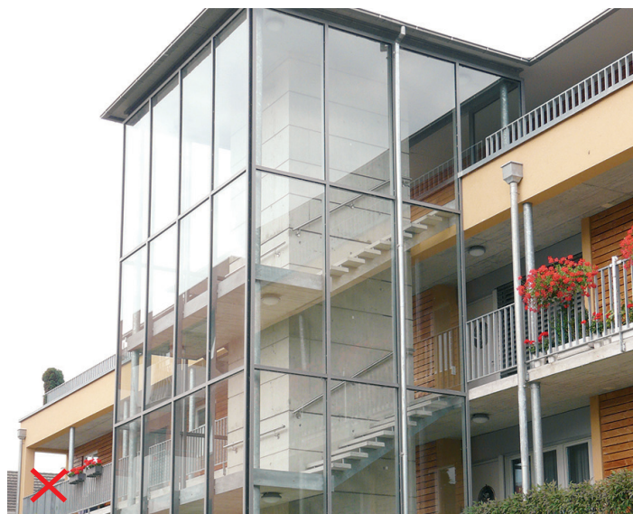
Illustration 17: Cette cage d'escalier présente une grande transparence – un danger pour les oiseaux. Il faudrait d'abord marquer les éléments latéraux. © Archives de la Station ornithologique suisse
